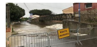
Sécurisation passage à gué
