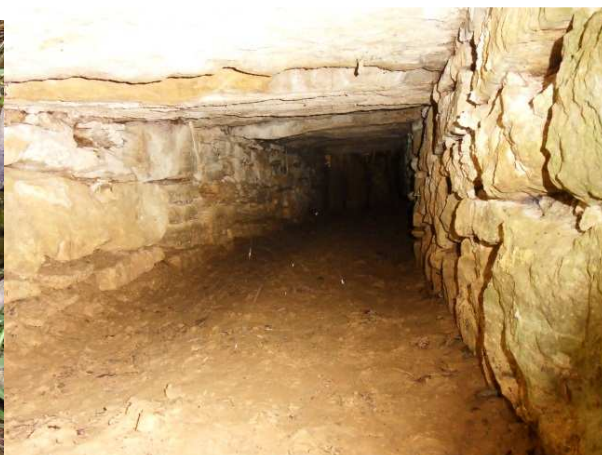
Tunnel d'écoulement des eaux sous le chemin, vers le ruisseau (section h 60cm x l 80 cm)
