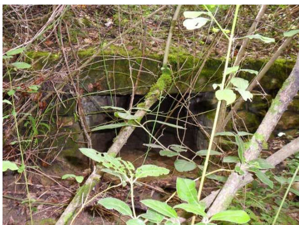
Tunnel d'écoulement des eaux sous le chemin, vers le ruisseau (section h 60cm x l 80 cm)
